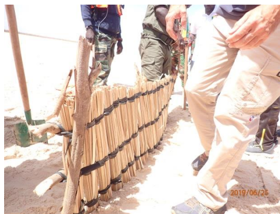
Essai du prototype sur site
