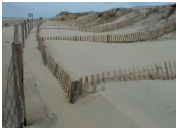
Exemple d'un maillage de ganivelles sur le littoral méditerranéen
