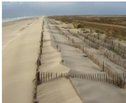
Exemple d'un maillage de ganivelles sur le littoral méditerranéen
